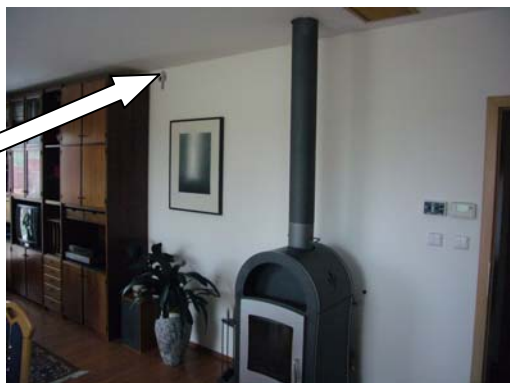
Obr.12 Umístění kombinovaného čidla teploty prostoru a vlhkostního čidla
