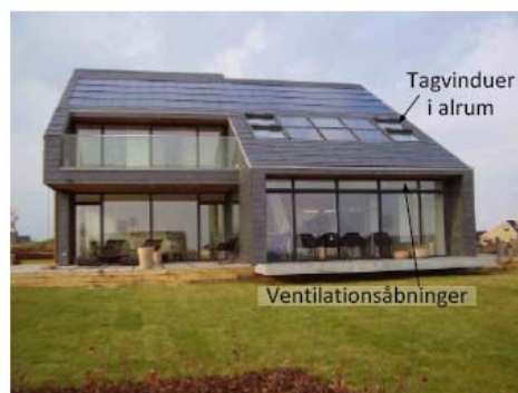
Obr. 6 Rozmístění oken pro automaticky řízené přirozené větrání (VKR 2010)
