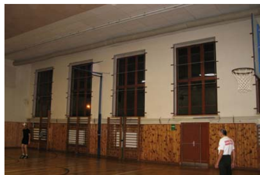
Obr. 3 Textilní vyústka je vedená nad okny (1,3 m od oken), přívod vzduchu je směřován šikmo vzhůru do prostoru
