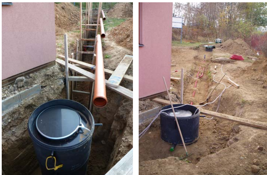
Obr. 2 Výstavba ZVT: a) usazování kontrolní šachty, b) zasypávání výkopu
