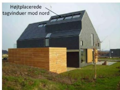
Obr. 6 Rozmístění oken pro automaticky řízené přirozené větrání (VKR 2010)
