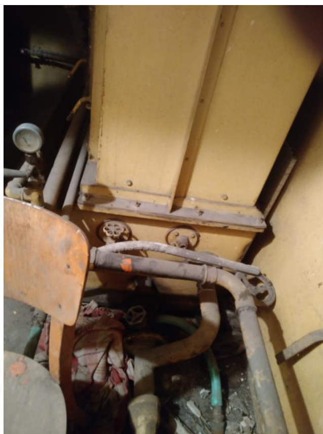
Filtrační sekce původní klimatizace jeviště
