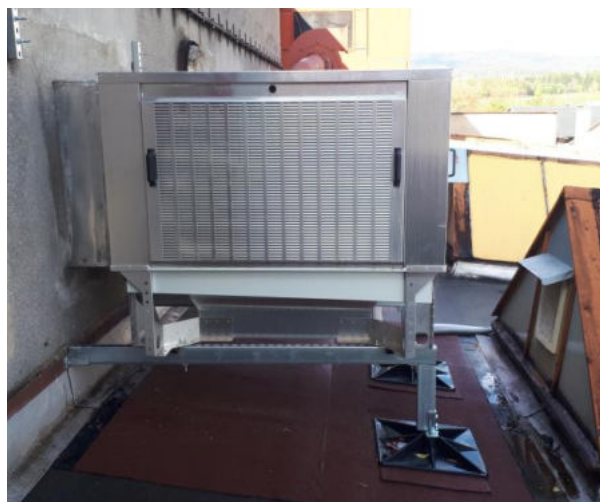
Obr. 6, 7 Výhodnou alternativou je umístění vedle budovy a průchod přes boční stěnu nebo stávající okno, pokud je vedle haly (nebo na sousední střeše) volný prostor
