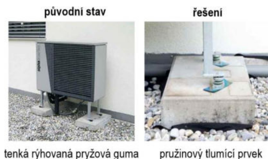
Obr. 12 Náhrada pryžových prvků pružinovými [7]
