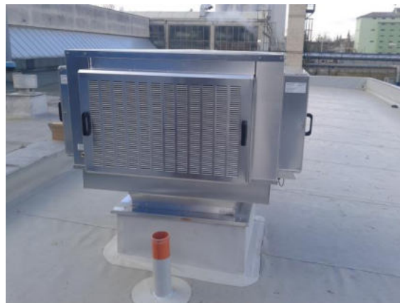
Obr. 3, 4 Umístění jednotky CoolStream na střešní podsadě je nejjednodušším způsobem instalace pro velké i menší chladicí projekty
