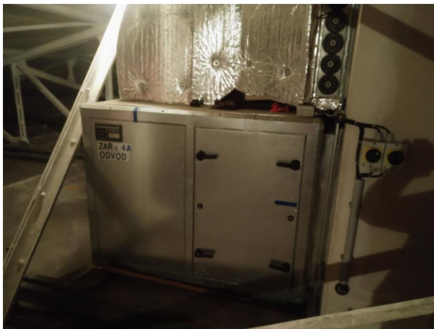
Odsávací jednotka z hlediště umístěná v krovu
