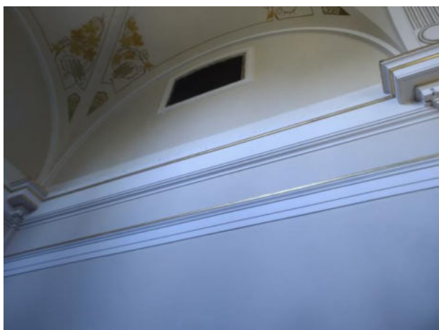
Přívodní mřížka ve foyer ve 2.NP
