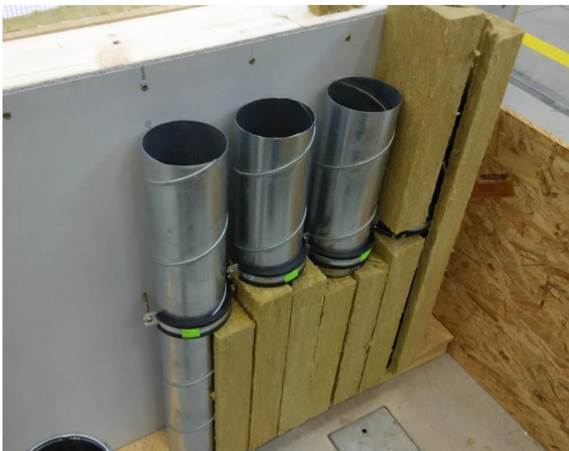
Obr. 2 Systém větrání integrovaný do panelu obvodového
