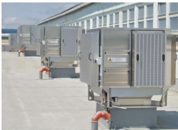
Obr. 3, 4 Umístění jednotky CoolStream na střešní podsadě je nejjednodušším způsobem instalace pro velké i menší chladicí projekty
