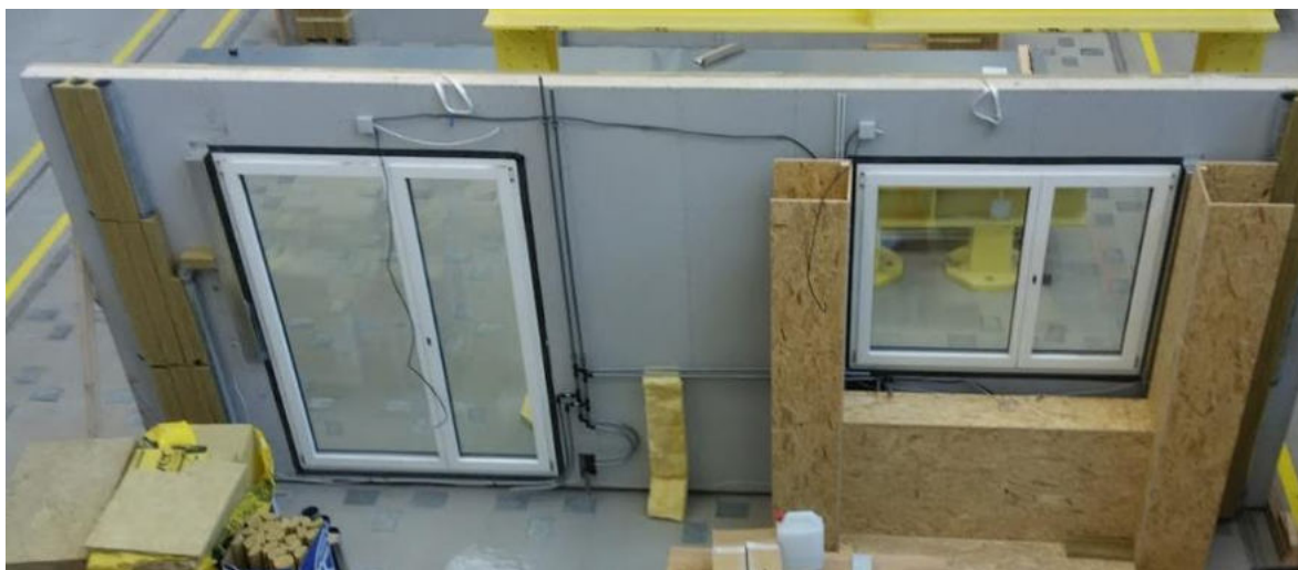
Obr. 1 Montáž experimentálního panelu
