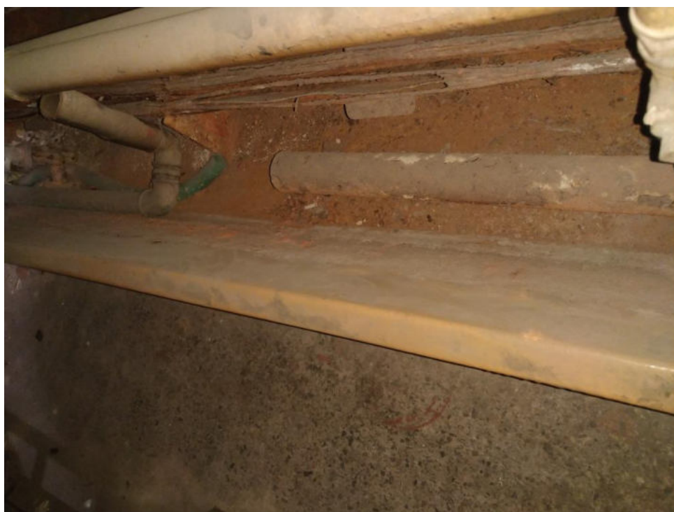
Pohled do adiabatické pračky původního klimatizačního zařízení pro jeviště
