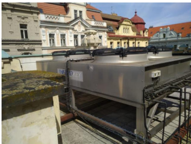
Kondenzátory chladicích jednotek
