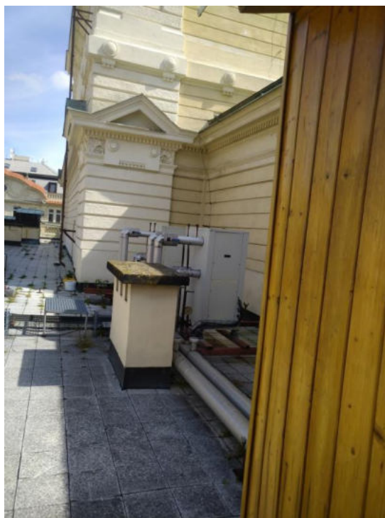
Odsávací jednotka z hlediště umístěná v krovu
