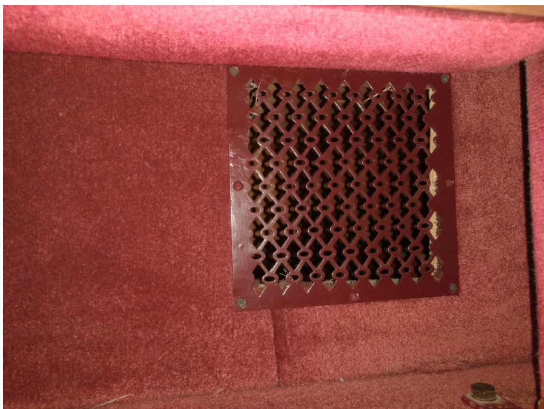
Přívodní mřížka pod sedadly na balkoně hlediště
