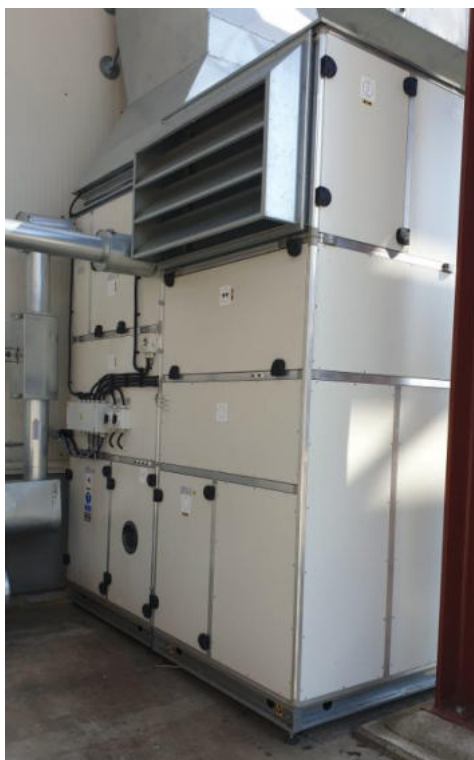
Obr. 4b Umístění vertikální VZT jednotky
