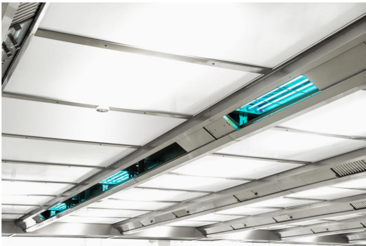
Obr. 7 UV-C záření rozkládá organické sloučeniny
