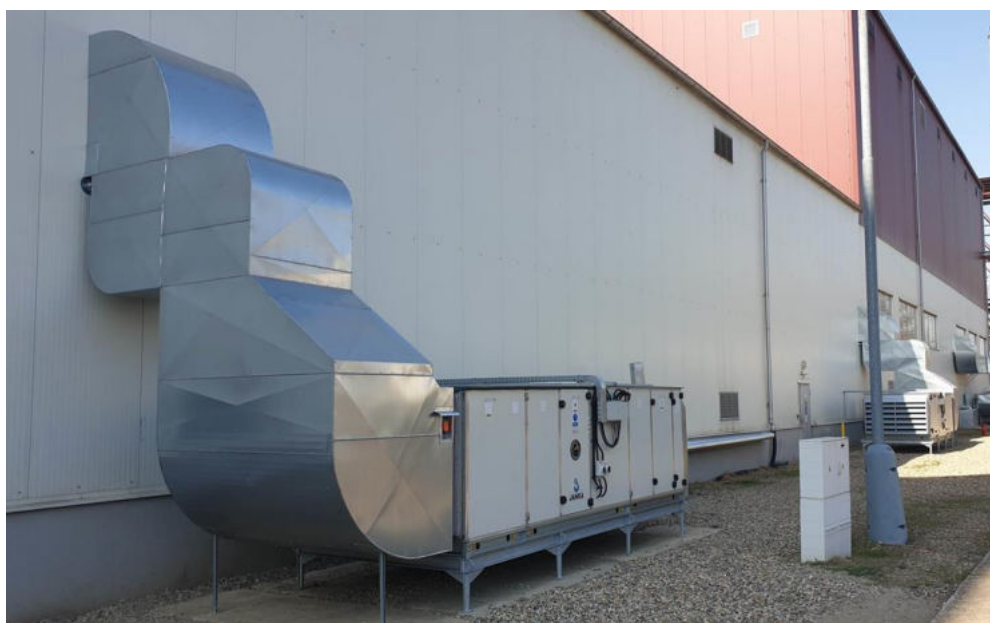
Obr. 4a Umístění VZT jednotek – realizace projektu
