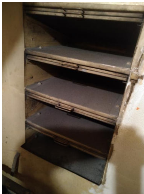
Filtrační sekce původní klimatizace jeviště
