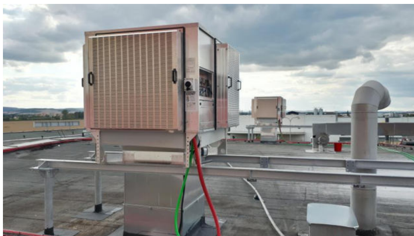
Obr. 5 Možné je i umístění jednotky CoolStream na střešní ocelovou konstrukci, pokud není možno vytvořit výměnu pod střechou
