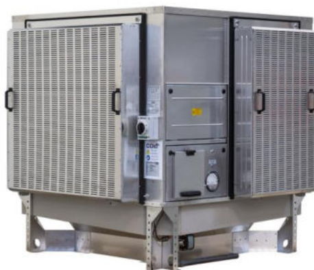
Obr. 1 Hlavní součást adiabatického chladicího systému CoolStream S•T•A•R – venkovní adiabatická komora
