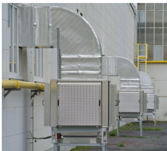
Obr. 6, 7 Výhodnou alternativou je umístění vedle budovy a průchod přes boční stěnu nebo stávající okno, pokud je vedle haly (nebo na sousední střeše) volný prostor
