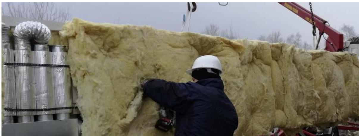
Obr. 3 Instalace panelů na experimentální objekt
