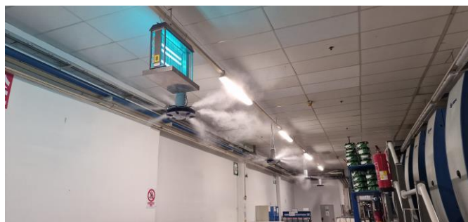
Zvlhčovací moduly s integrovanými ventilátory a filtry pro zachycení polétavého prachu
