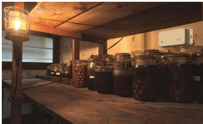
Obr. 3 Čidlo radonu ADS-RN1 ve sklepe
