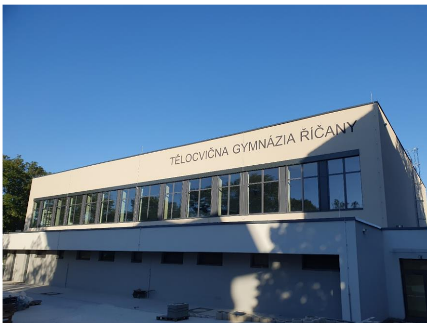
Obr. 3 Gymnázium Říčany – Tělocvična. Dodávka 8 vzduchotechnických jednotek včetně školních
