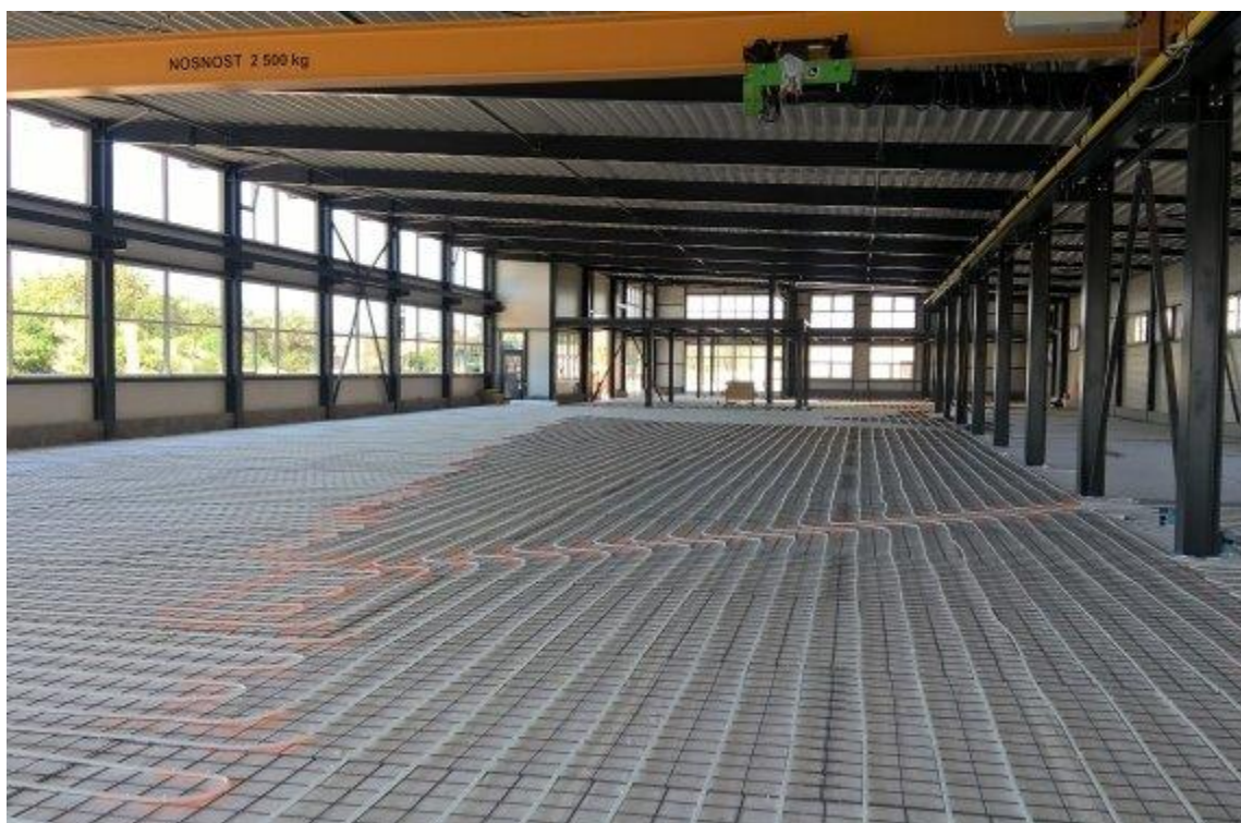
Obr. 3 Hala pro lehkou montáž, instalace sálavého systému vytápění a chlazení
