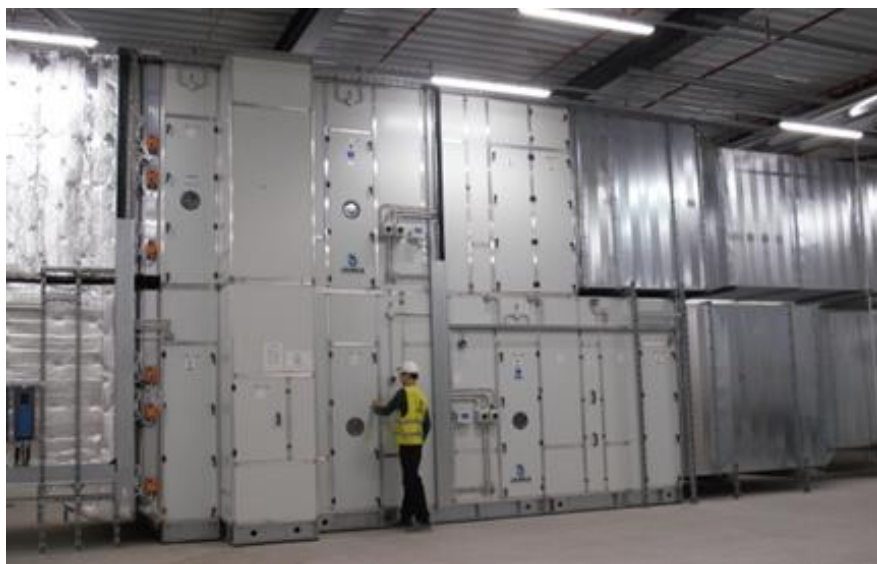
Obr. 3 VZT jednotka JAGUAR LAND ROVER strojovna Nitra
