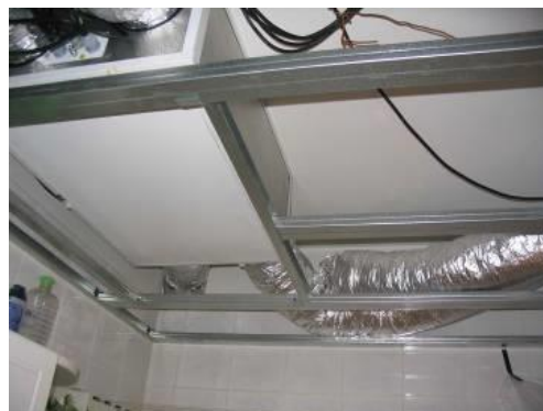
Obr. 2 Schéma domu s decentralním větráním a příklad jednotky před jejím zakrytím sádkkartonem, zajišťující individuální větrání bytu
